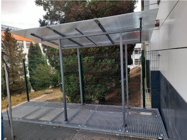
Obr. č. 1 Plošina s prístreškom pripravená na inštaláciu malého pyrolýzneho reaktora
