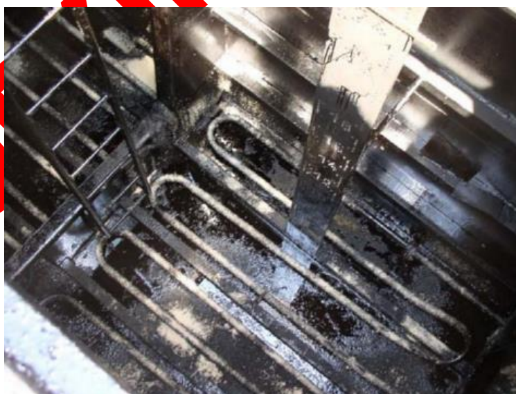
Ob. 6 Čistenie vo výbušnom prostredí „nádobá“ so zvyškami na báze oleja.
